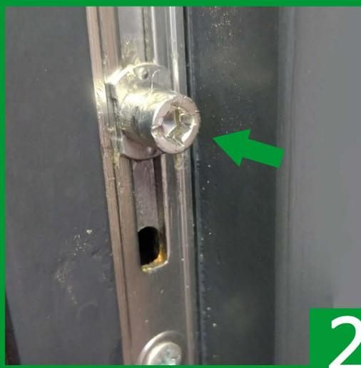
Über das Drehen der Schließnocken, von denen Sie mehrere Rund um das Fenster verteilt vorfinden, kann der Fensterflügel stärker oder weniger stark an den Rahmen herangezogen werden, wenn das Fenster verriegelt wird.
