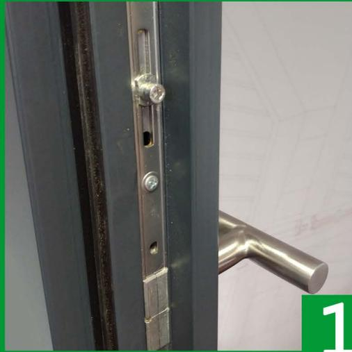
Über die Schließnocken lässt sich der Anpressdruck des Fensterflügels an den Fensterrahmen im verriegelten Zustand einstellen.
