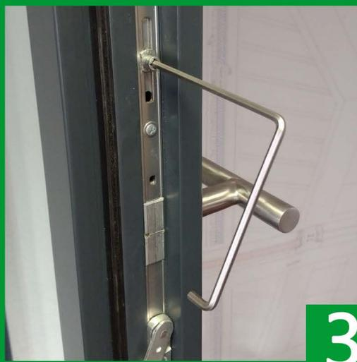
Um den Anpressdruck einzustellen benötigen Sie einen 4er Imbusschlüssel.
