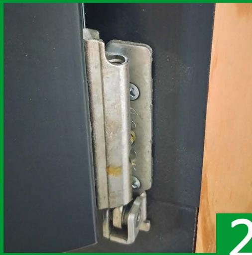
Entfernen Sie zunächst die graue Schutzkappe auf dem Band indem Sie diese einfach nach oben hin abziehen.
