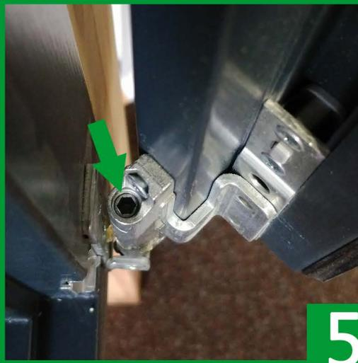
Auf diesem Bild von oben ist die Stellschraube im Band gut zu erkennen.
